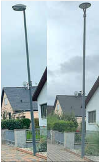
Alte (links) und neue (rechts) Straßenbeleuchtung.
