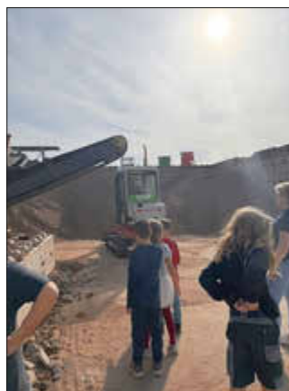
Bei Gerach Baumaschinen und Container in Landau
