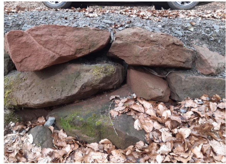
Sickerpackung zum gedrosselten Ablauf aus Retentionsraum
