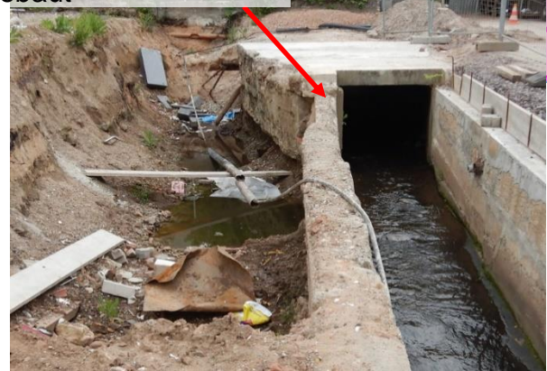
Geschlossener Verbau, wird dauerhaft zurückgebaut
