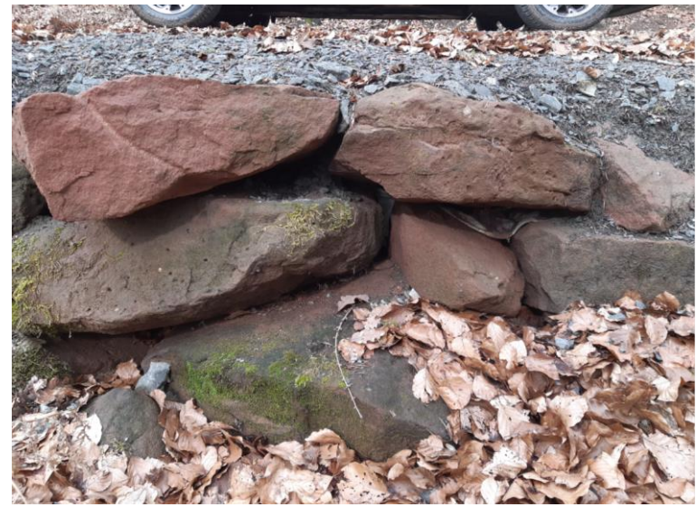
Sickerpackung zum gedrosselten Ablauf aus Retentionsraum
