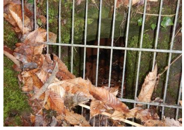
Aus Sandsteinen gesetzter Durchlass mit Zaunelement als Rechen
