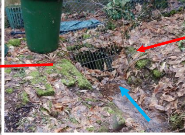
Aus Sandsteinen gesetzter Durchlass mit Zaunelement als Rechen
