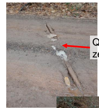
Keine Wasserführung, Ablauf über Weg => Erosion
