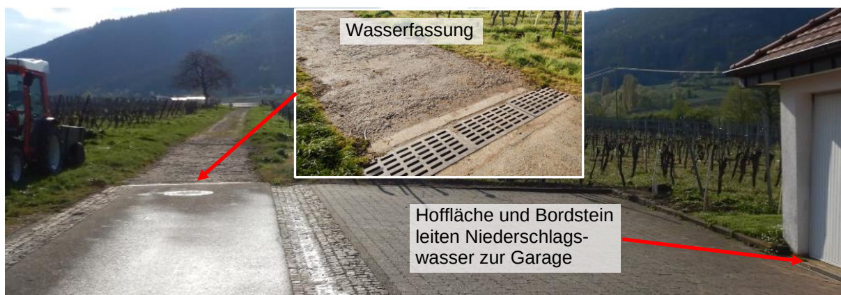
Abbildung 26 Wasserfassung am Wirtschaftsweg
