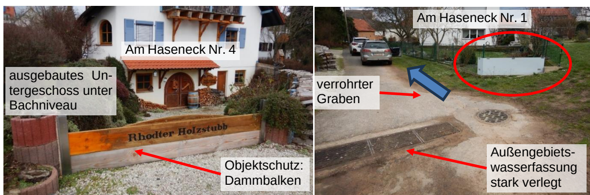
Abbildung 24 Situation Ortseingang Am Haseneck / Verrohrter Leißelgraben
