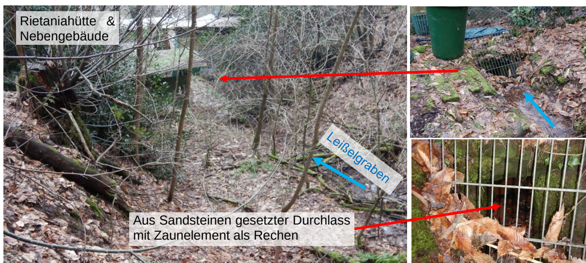
Abbildung 13 Rietaniahütte und Verrohrung
