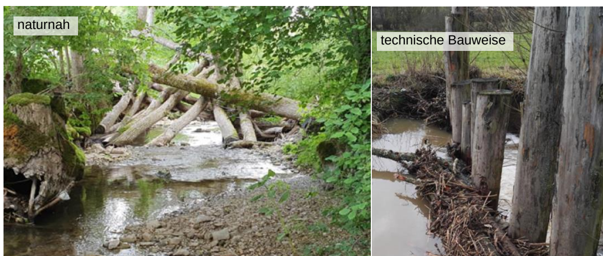
Abbildung 17 Beispiele Grobrechen (naturnah und technisch)
