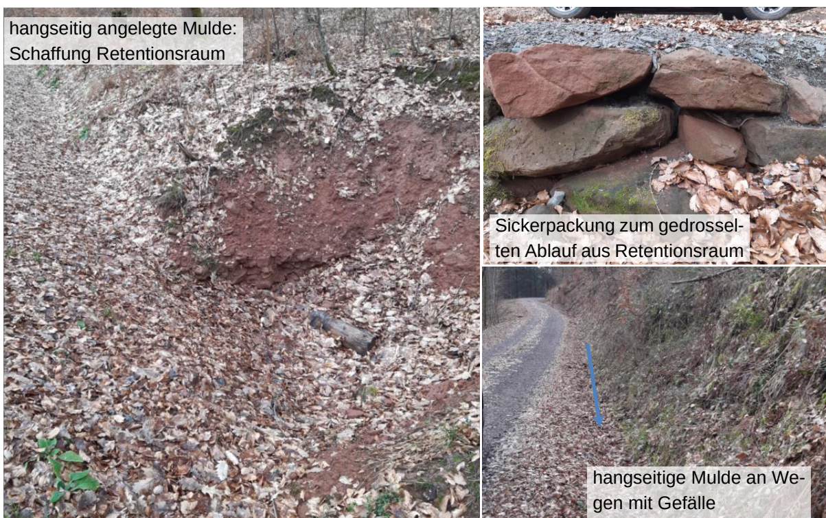
Abbildung 16 Beispiel für eine hangseitig angelegte Mulde zu einem Rückhalt mit Sickerpackung
