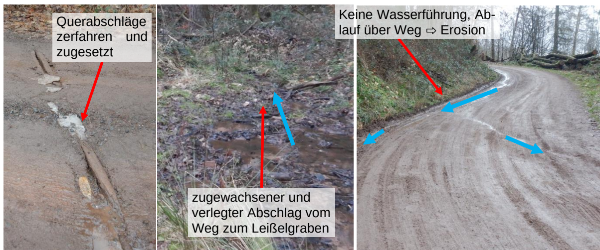
Abbildung 11 Situation Wegeentwässerung oberhalb Rietaniahütte
