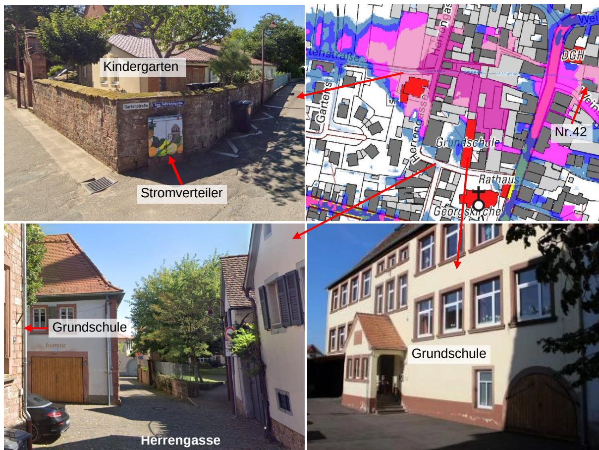
Abbildung 32 Situation Mündung Gartenstraße auf Herrengasse (Kindergarten) und Grundschule
