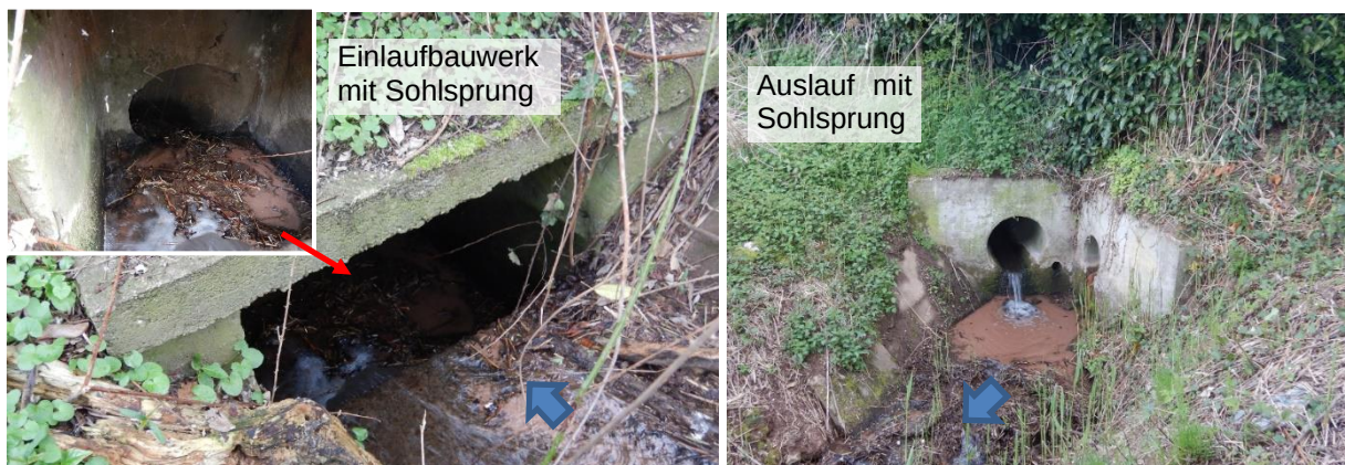
Abbildung 20 Beginn und Ende Verrohrung Flur 32/21
