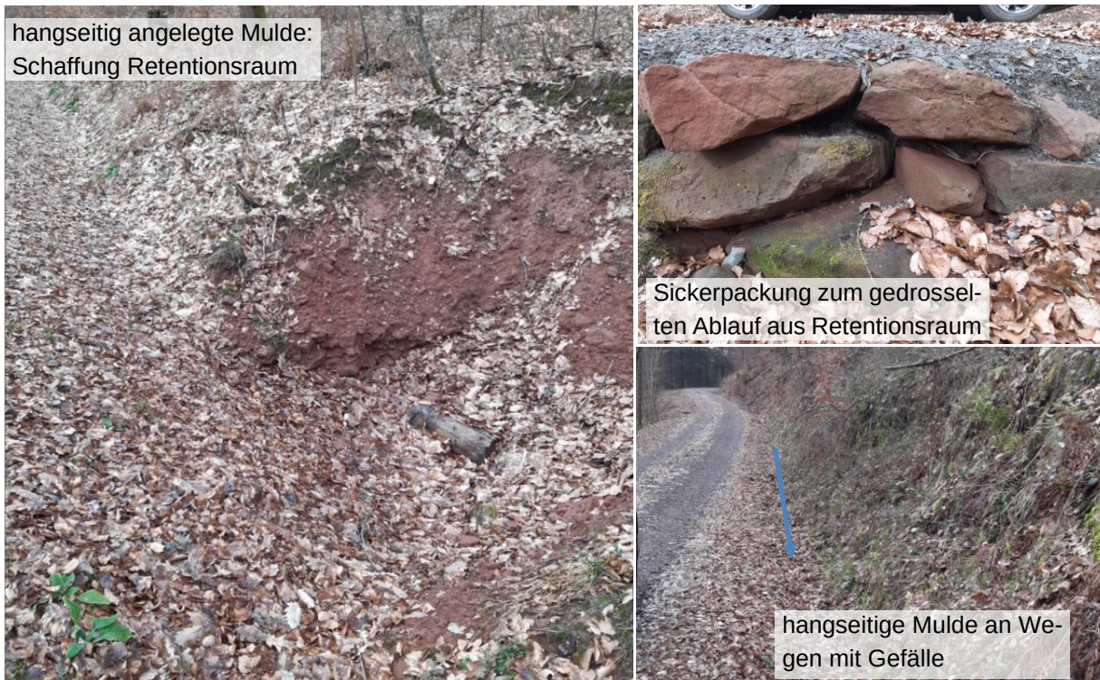
Abbildung 15 Beispiel für eine hangseitig angelegte Mulde zu einem Rückhalt mit Sickerpackung
