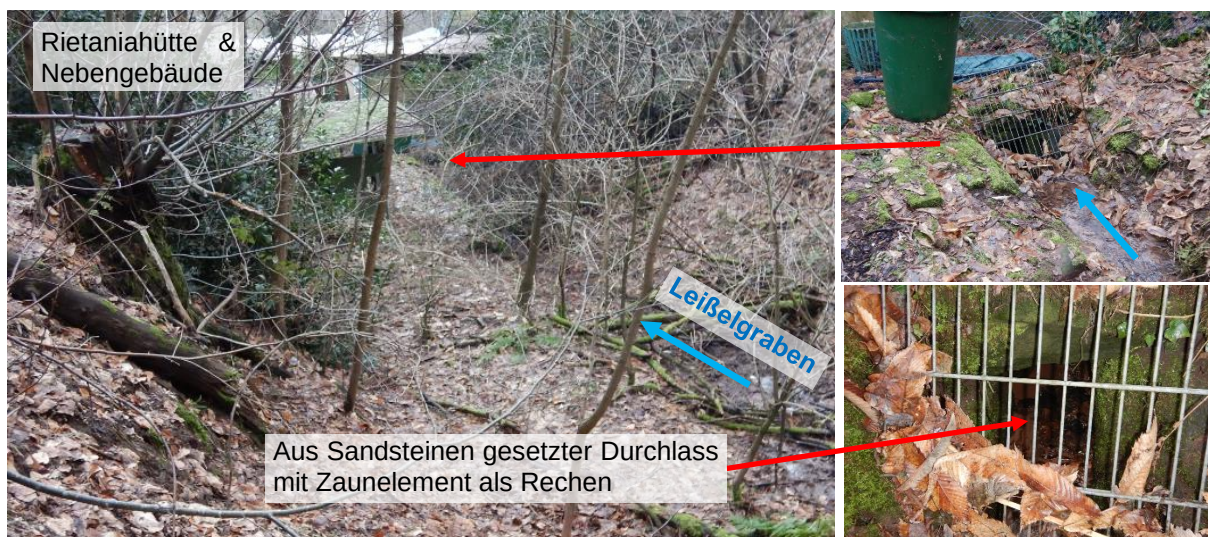
Abbildung 12 Rietaniahütte und Verrohrung
