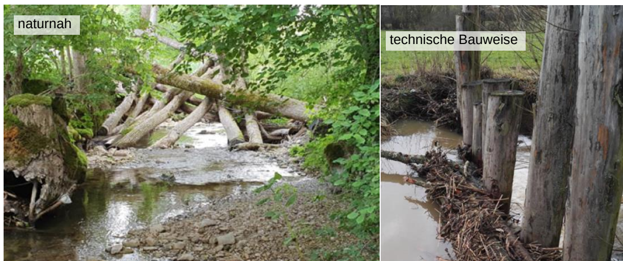
Abbildung 16 Beispiele Grobrechen (naturnah und technisch)
