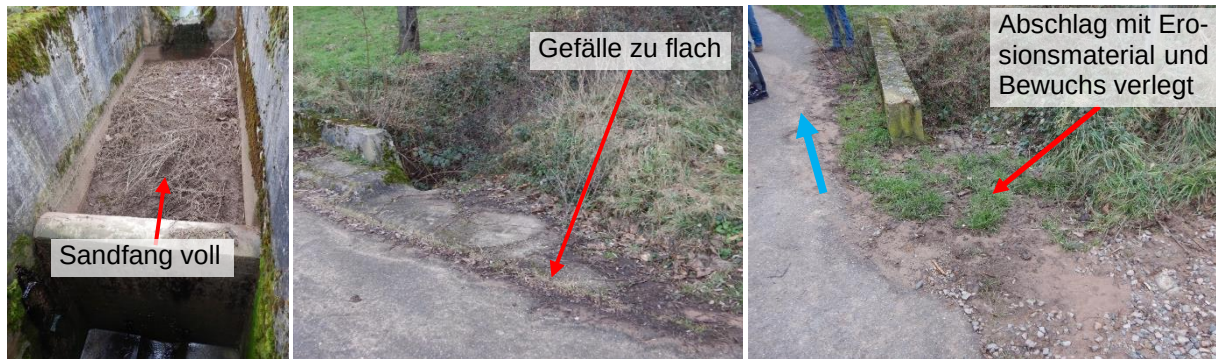
Abbildung 22 Situation der Entwässerungsanlagen oberhalb Weyher bei der Begehung
