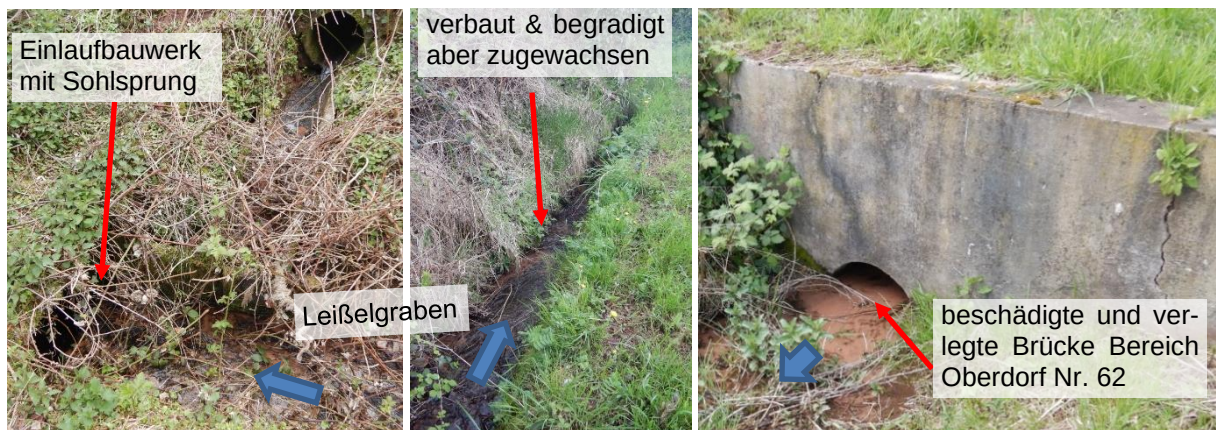
Abbildung 19 Situation Leißelgraben zwischen Oberdorf Nr. 62 und Alte Rebschule
