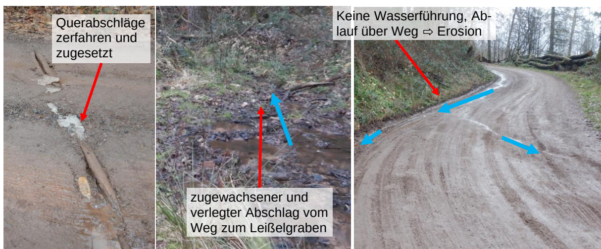
Abbildung 10 Situation Wegeentwässerung oberhalb Rietaniahütte
