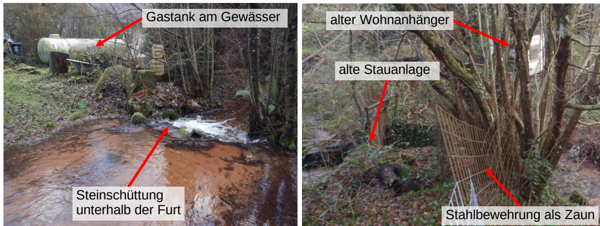
Abbildung 28 private Furt, Ablagerungen im und Zäune durch das Gewässer im Bereich Zum Hilschweiher
