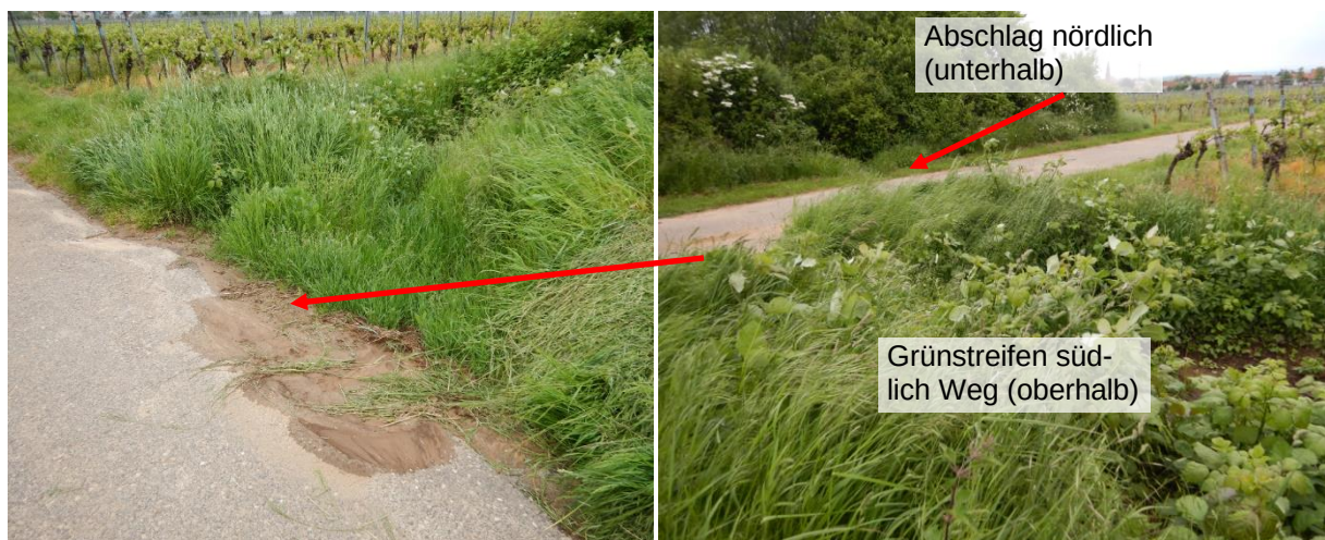
Abbildung 38 Grünstreifen mit Rückhaltefunktion / zugesetzte Abschläge
