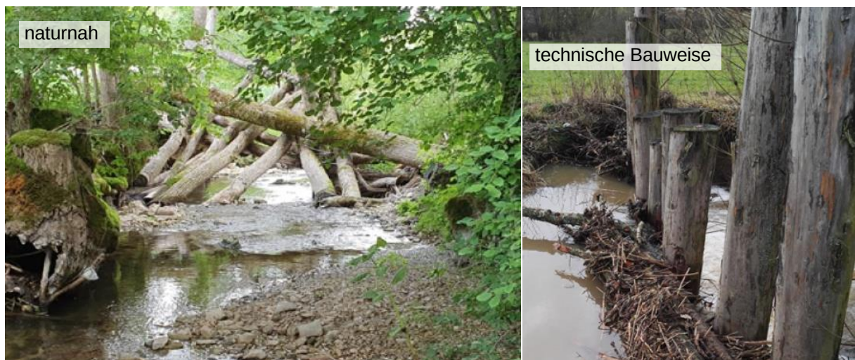
Abbildung 14 Beispiele Grobrechen (naturnah und technisch)
