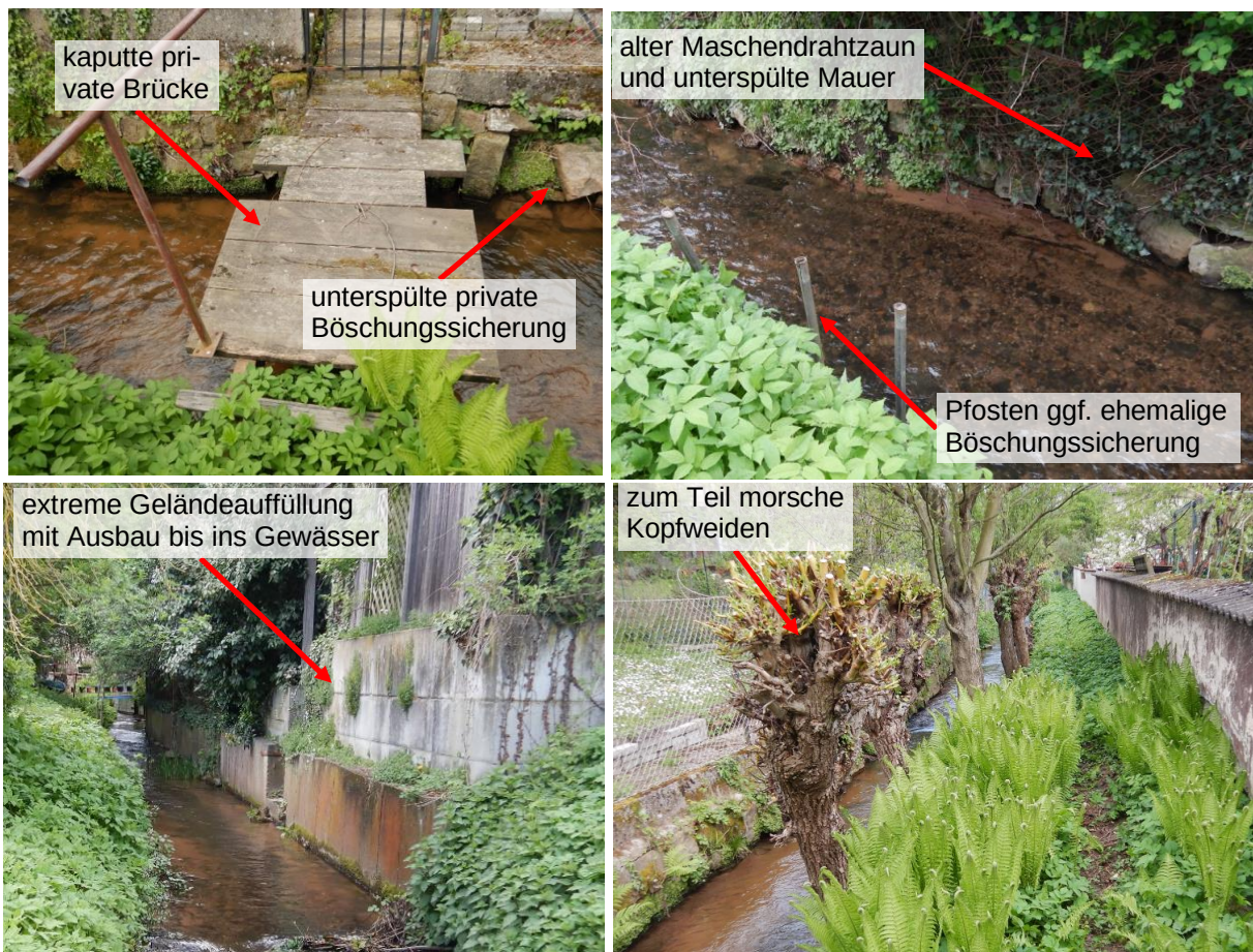
Abbildung 41 Situation Triefenbach im Bereich Poststraße / Spitalstr.
