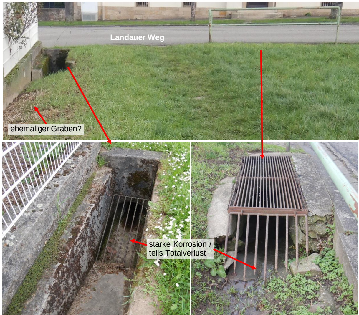
Abbildung 36 Außengebietswasserfassungen am Landauer Weg (südlich Nr. 9)
