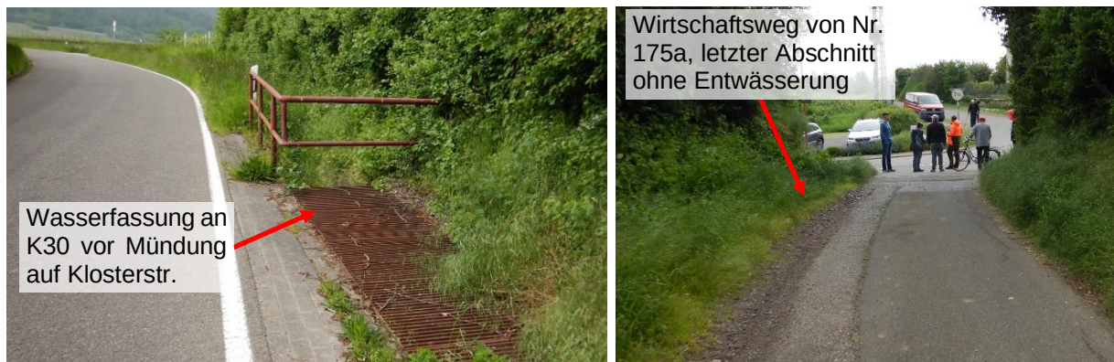
Abbildung 33 Situation Wasserfassung K30 und Wirtschaftsweg von Nr. 175a
