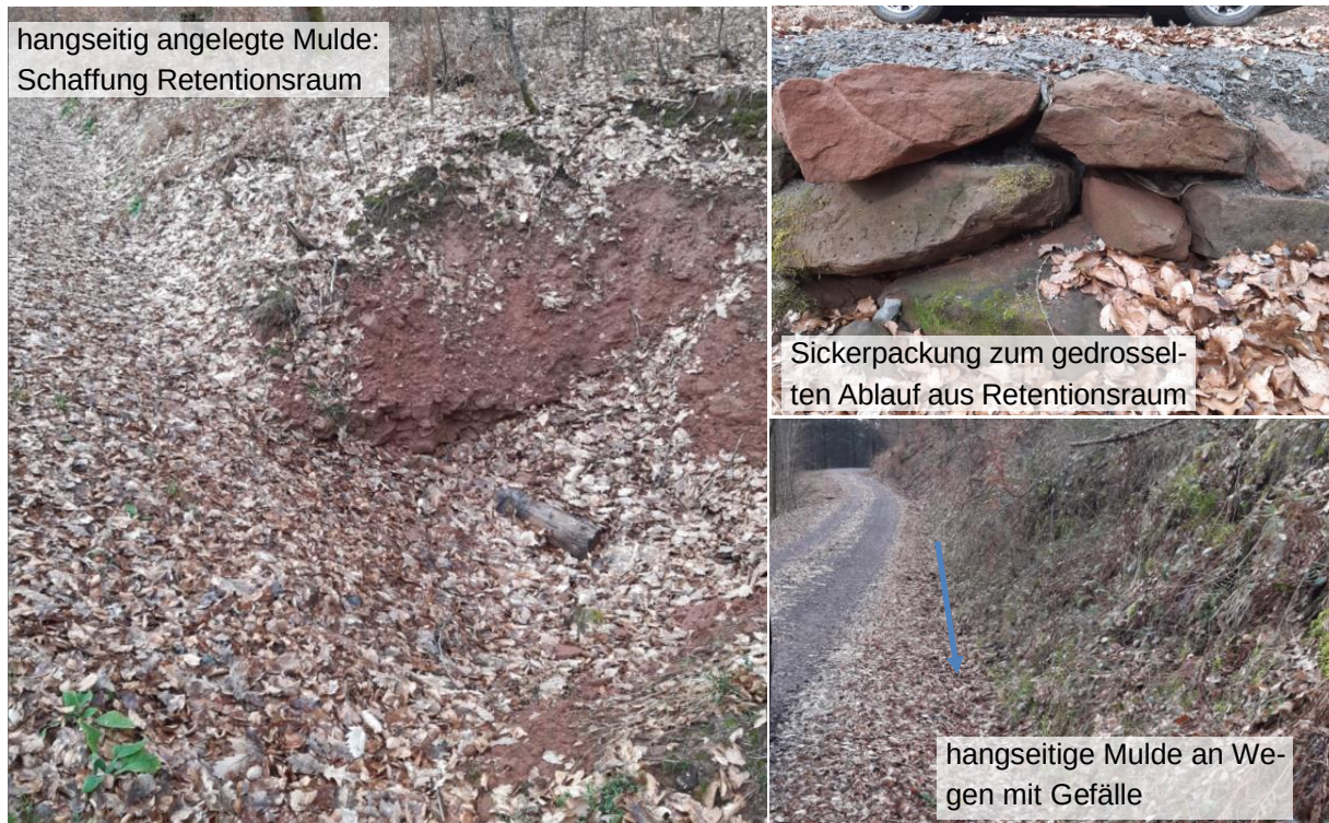
Abbildung 13 Beispiel für eine hangseitig angelegte Mulde zu einem Rückhalt mit Sickerpackung
