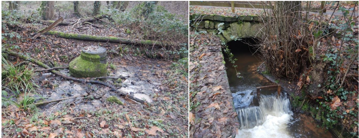
Abbildung 25 Links: Schacht mittig im Triefenbach Rechts: alte Brücke mit Stauanlage / altes Kneippbad
