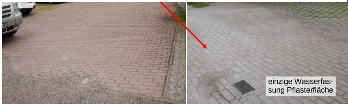
Abbildung 47 Situation im Bereich Blücherstr. 16a und Parkplatz Bahnhofstraße 28 -30
