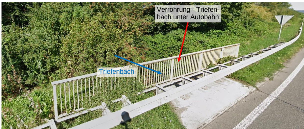
Abbildung 53 Situation Beginn Verrohrung Triefenbach unter Autobahn (Quelle: Google Street View)
