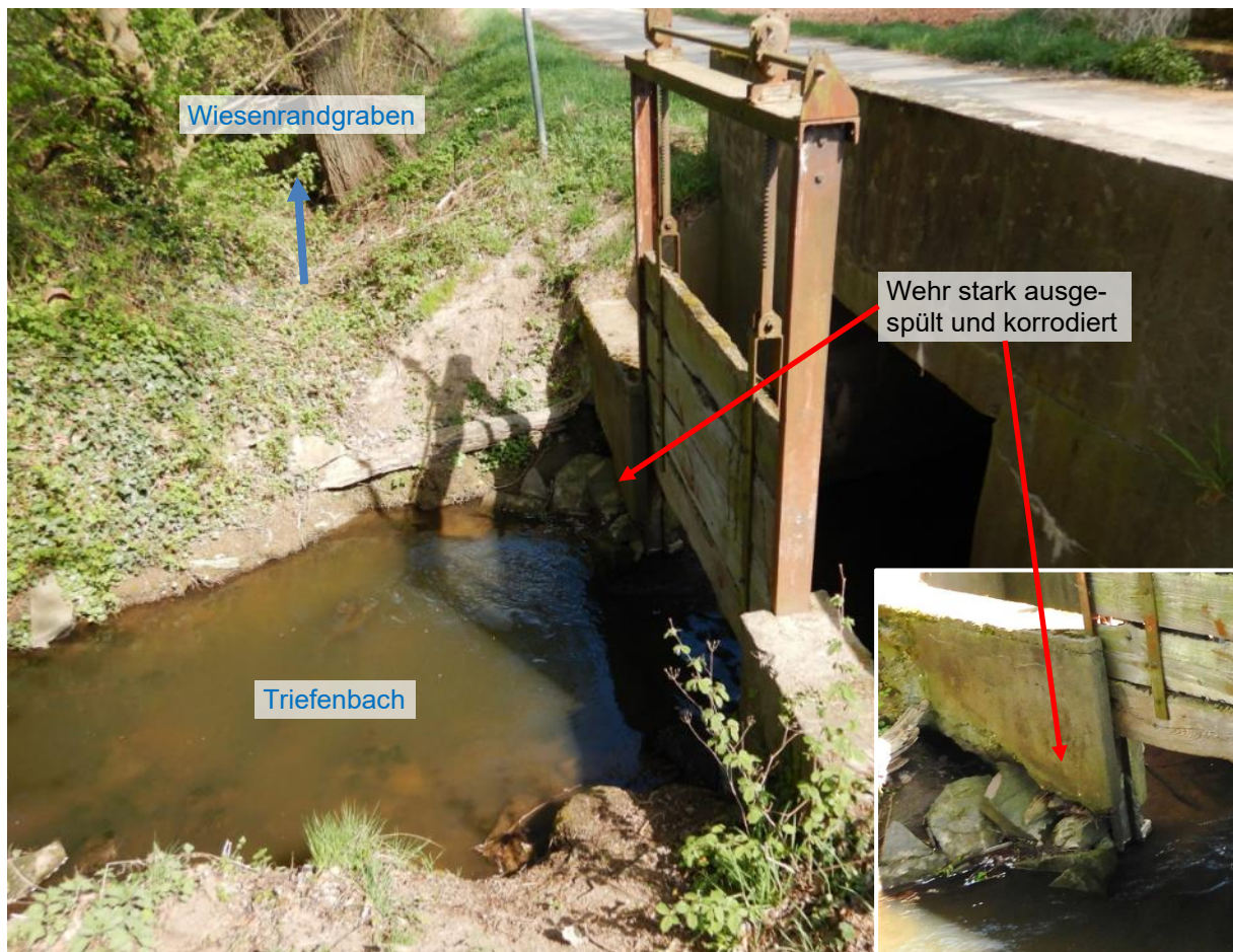
Abbildung 10 altes Wehr Abzweig Wiesenrandgraben
