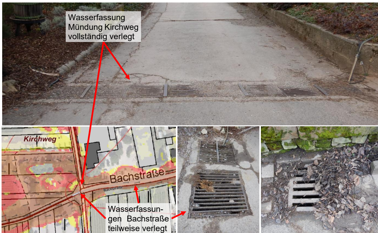
Abbildung 16 Entwässerungssituation am westlichen Beginn der Bachstraße
