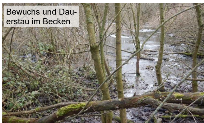
Abbildung 10 innerhalb Rückhaltebecken Burrweilerweg
