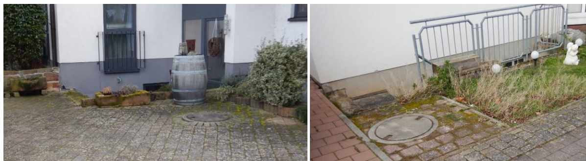
Abbildung 21 Beispiele für außenliegende gefährdete Kellerzugänge Am weißen Kreuz
