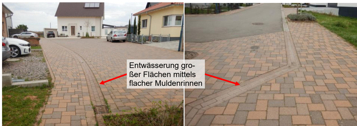
Abbildung 23 Straßenentwässerung Neubaugebiet Rieshübel
