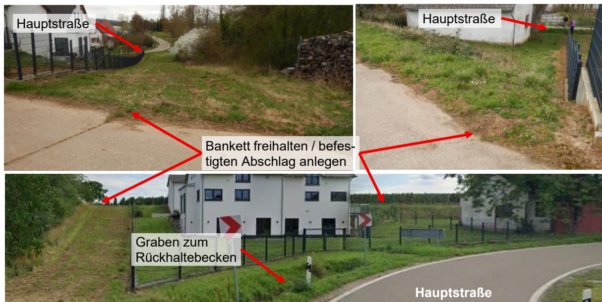
Abbildung 25 Maßnahmenvorschläge Am Falltor / Wirtschaftsweg südöstlich Freimersheim
