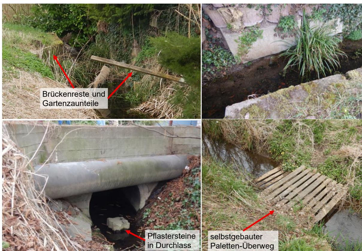
Abbildung 20 Mühlbach: Anlagen und Abflusshindernisse Gewässer
