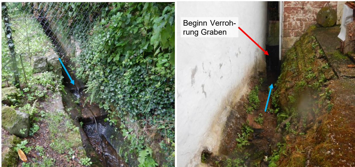
Abbildung 16 Beginn Verrohrung im Bereich Zum Sonnenberg Nr. 8
