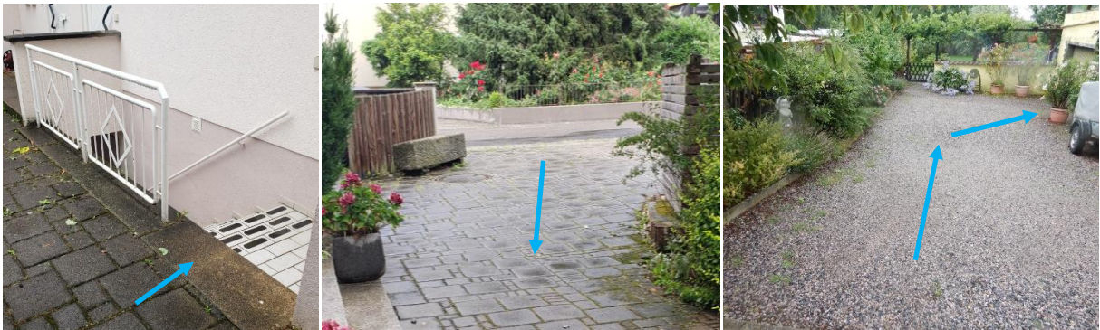
Abbildung 20 Beispiel tiefliegender Zugänge / Zufahrten aus dem Straßenraum und ebenerdiger Kellerabgang
