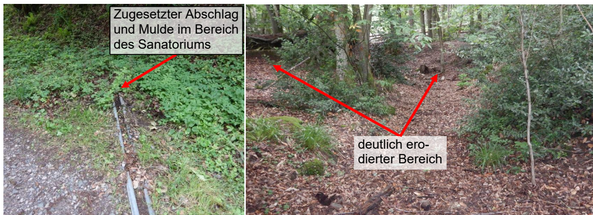
Abbildung 12 verlegte Entwässerungsrinne und Tiefenlinie oberhalb Sanatoriums
