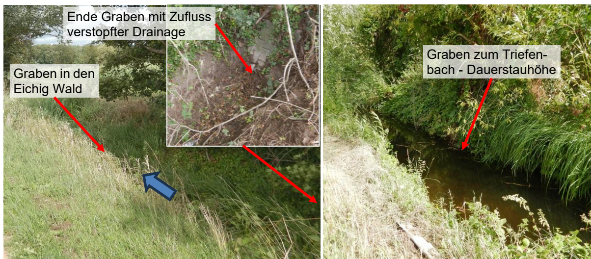
Abbildung 26 Gräben auf Höhe Mündung Brühlgraben zwischen Triefenbach und Wolfsgraben
