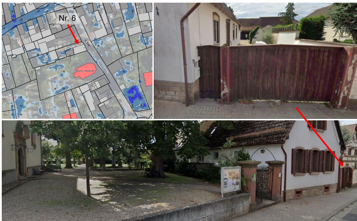
Abbildung 11 Überflutungsgefährdung Kirchstraße Nr. 6 und 8
