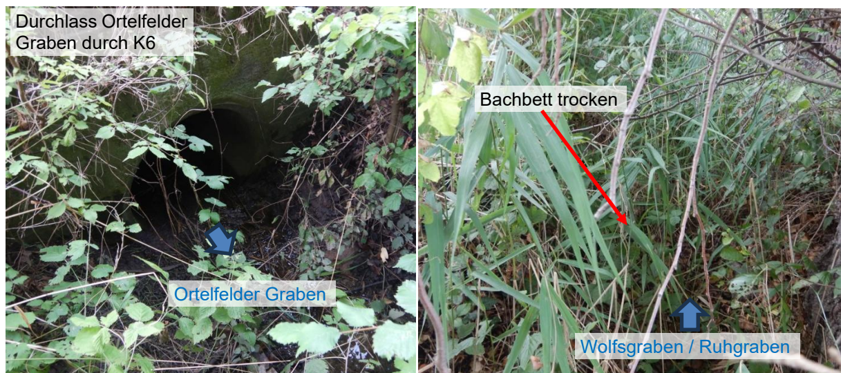
Abbildung 21 links: Durchlass Ortelfelder Graben unter K6, rechts: Ruhgraben / Wolfsgaben
