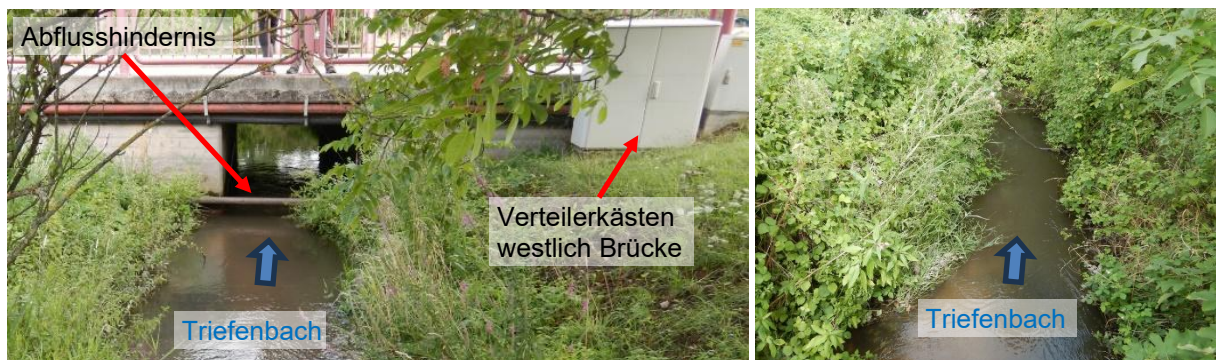
Abbildung 15 Situation Brücke Geinsheimer Straße (L530)
