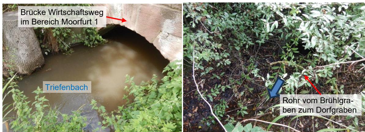
Abbildung 25 links: Brücke Triefenbach Moorfurt 1
