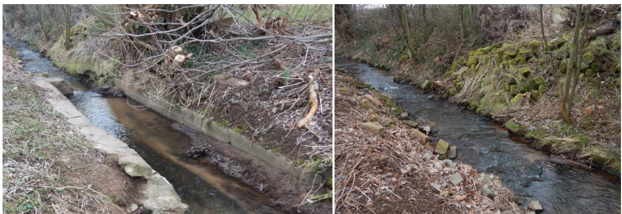
Abbildung 10 Anlagenreste der Wasserregulierung sowie Steinschüttungen am Modenbach
