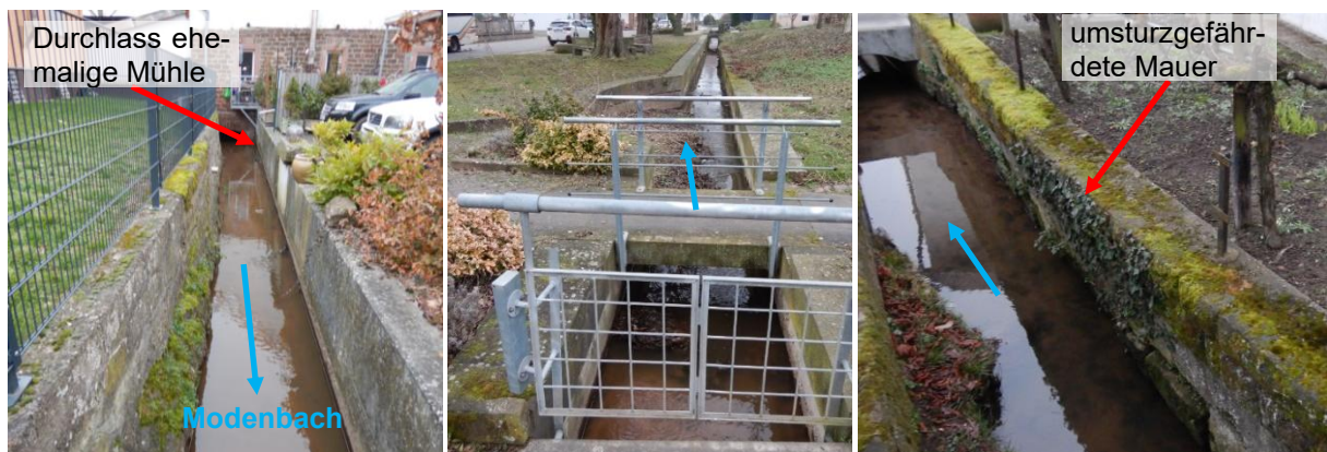
Abbildung 13 innerörtlicher Verbau Modenbach in Großfischlingen
