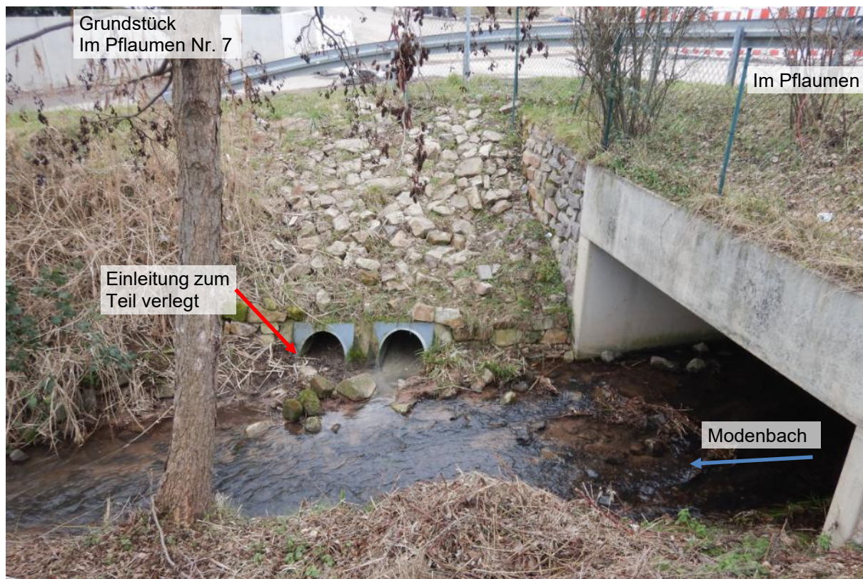
Abbildung 38 Situation Brücke und Niederschlagswassereinleitung „Im Pflaumen“
