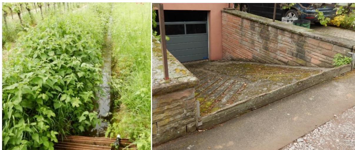
Abbildung 24 links: Wingertgraben oberhalb Am Hofstück rechts: Objektschutz in der Straße Am Hofstück
