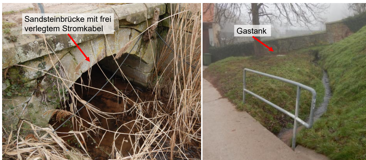
Abbildung 16 Situation Flutgraben und Mühlgraben des Modenbach im Bereich der Mühle
