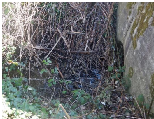
Abbildung 19 Verrohrung südlich Tennisplatz
