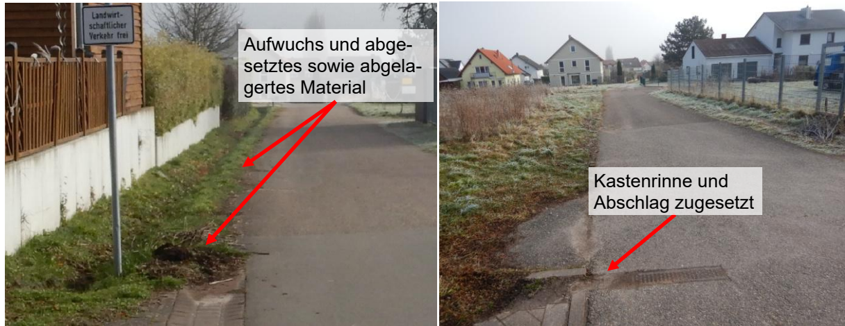
Abbildung 30 Niederschlagsentwässerung „Am Rosenkränzel“
