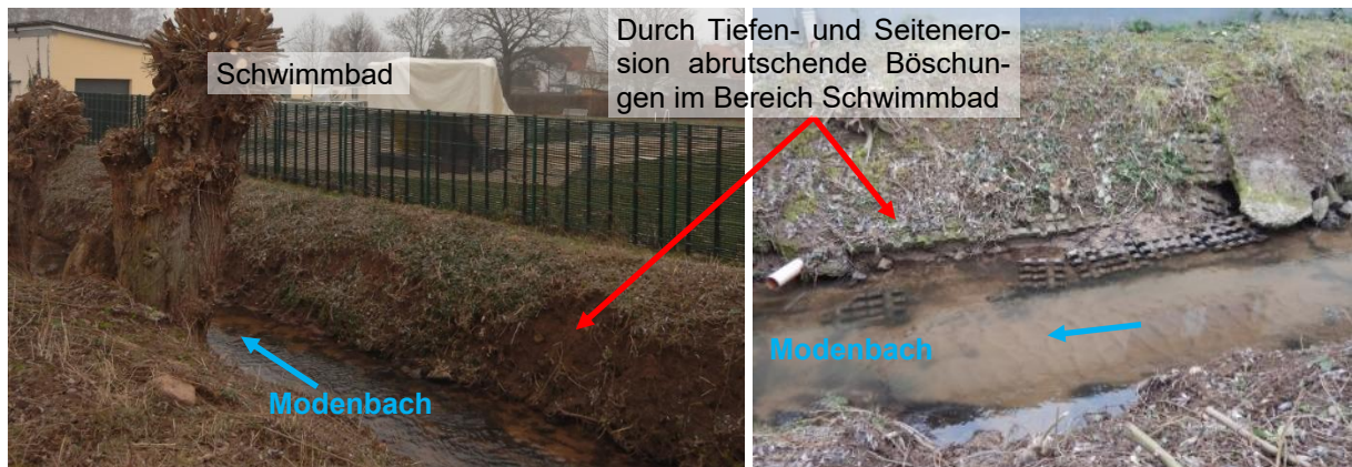
Abbildung 10 Modenbach im Bereich Schwimmbad Eckel
