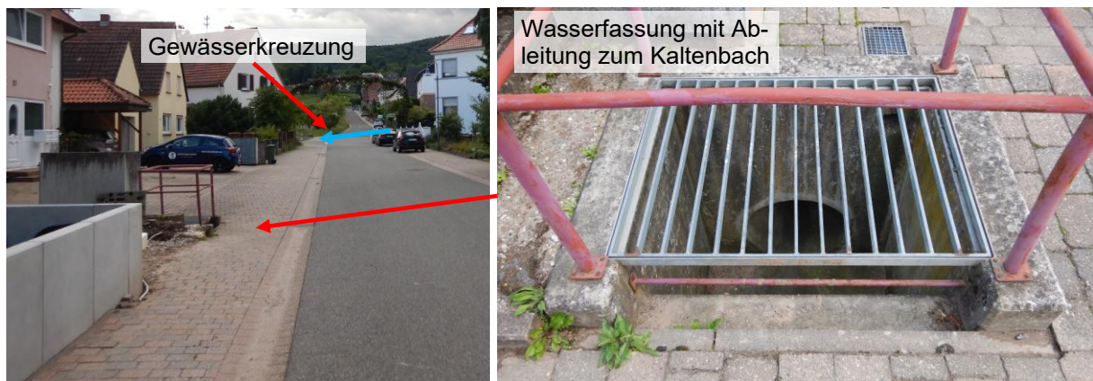
Abbildung 37 Weinstraße Gewässerkreuzung und Straßentiefpunkt mit Wasserfassung
