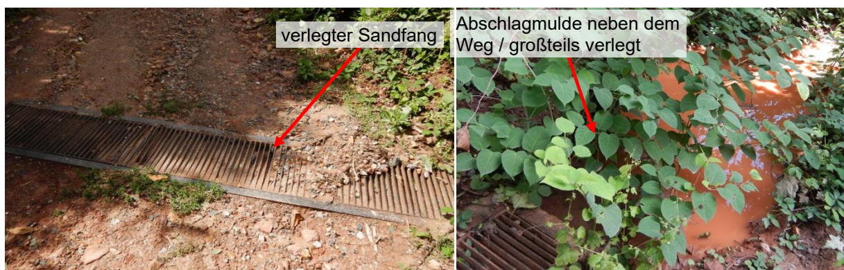
Abbildung 15 Beispielhafte Situation an einem der vielen Sandfänge
