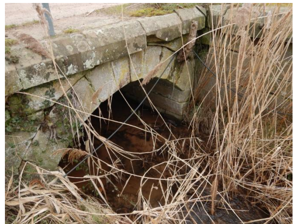
Abbildung 42 Kabel an Brücke Burrweiler Mühle
