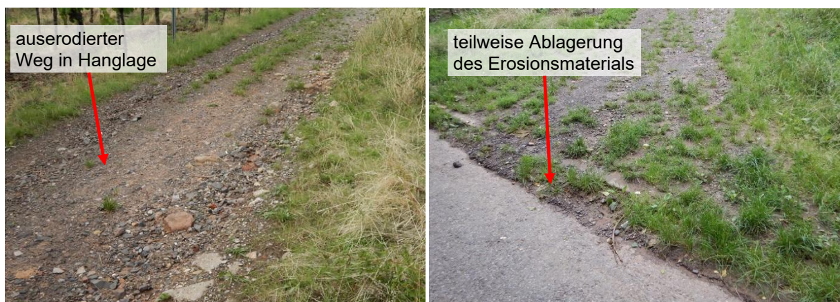
Abbildung 32 erodierter Wirtschaftsweg und Erosionsablagerung
