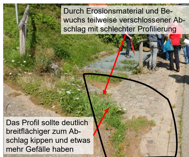
Abbildung 34 Sandfang Ortseingang „Am Schäwer“
