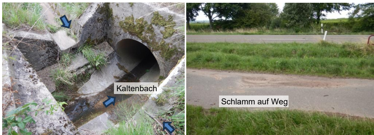
Abbildung 40 Zusammenfluss Straßengraben L519 mit dem Kaltenbach
